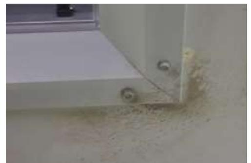
Visualisation des saletés en sorties et à la périphérie des déflecteurs d'air climatisé, poussières, graisses, dépôts carbonés et biofilm microbiens.
